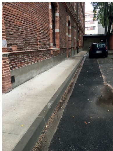
Élargissement du trottoir le long de la façade.
