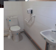
Création de 2 blocs sanitaires PMR au R+1 et R+2.
