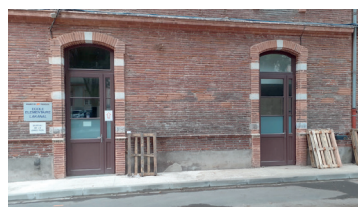
Remplacement des menuiseries extérieures par des portes tiercées : grande et petite ouverture
