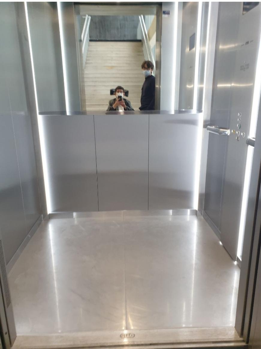
Miroir des ascenseurs positionnés trop haut ne permettant pas aux personnes en fauteuil roulant de reculer en sécurité en voyant bien le gabarit de leur fauteuil pour ne pas risquer de se cogner dans les portes ou les parois et pouvant empêcher de ressortir facilement
