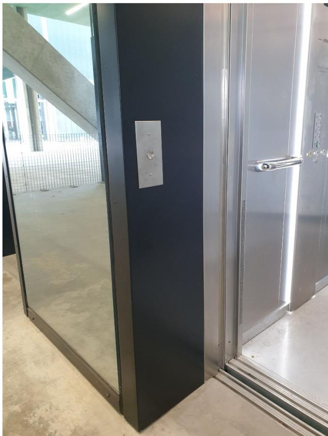
Bouton d'appel de l'ascenseur positionné à moins de 40 cm d'un angle rentrant (de la porte de l'ascenseur) ne permettant pas à une personne en fauteuil roulant de s'approcher pour appuyer sur le bouton elle-même
