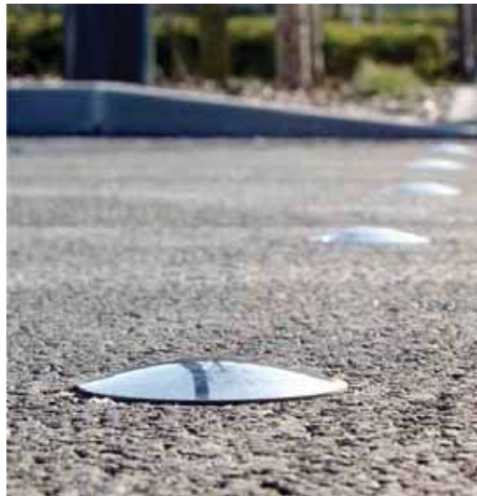
Mise en œuvre de clous
