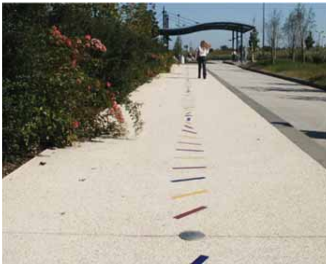
Béton avec incrustations
