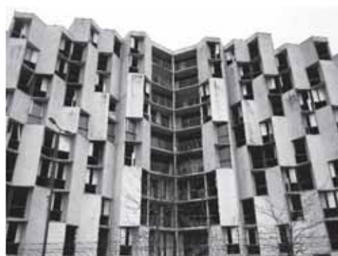
FIGURE 2 : RUE ARISTIDE MAILLOL, RÉSIDENCE LES CASTALIDES OU "L'IMMEUBLE DE LA HONTE" DÉMOLI EN 2019
