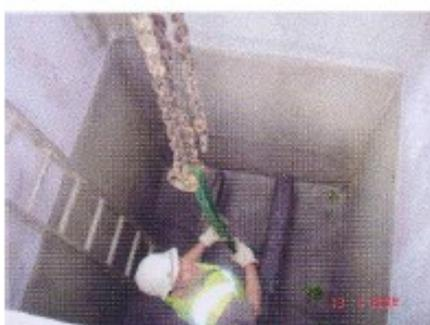
2-3-2 Mettre en place le cadre recouvrant le béton.
