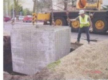
2-2-2- Les éléments sont positionnés dans le fond de fouille. On doit vérifier qu'ils sont de niveau, seuls ou deux à deux suivant la disposition prévue.
