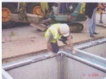
Lors de la mise en place des tubes (dès l'insertion des ces derniers), insérer le support guide de la plate forme de sécurité.
