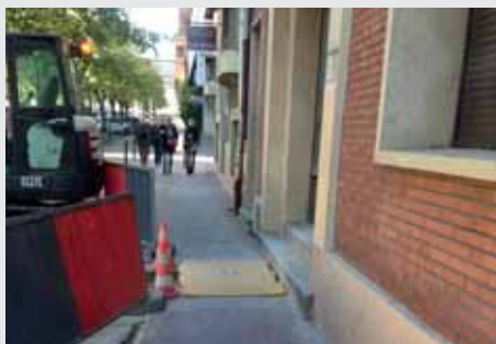
Pont piéton en plastique - Toulouse Métropole
