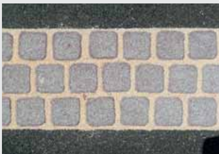
Détail pavés collés de délimitation voie cyclable/piéton
