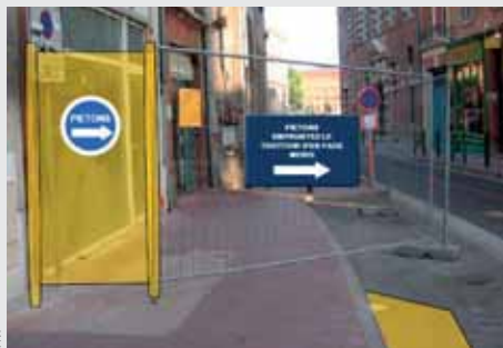
Travaux sur trottoir sans itinéraire accessible - Toulouse
