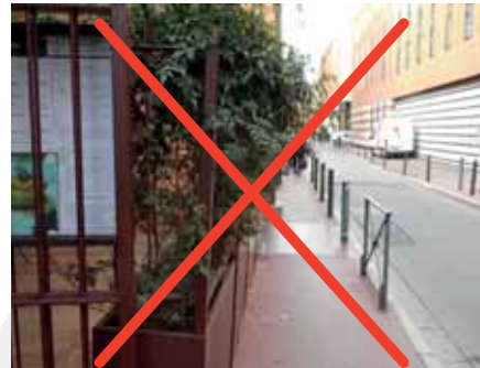
Végétation privée empiétant sur le cheminement
