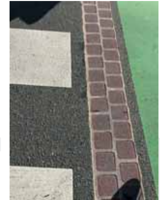
Délimitation Toulouse Métropole de passage piéton en pavés collés avec une traversée cycles
