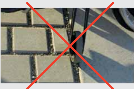
Non conforme bloquant les roues de fauteuil roulant - Toulouse
