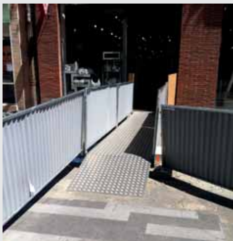
Pont piéton métallique
