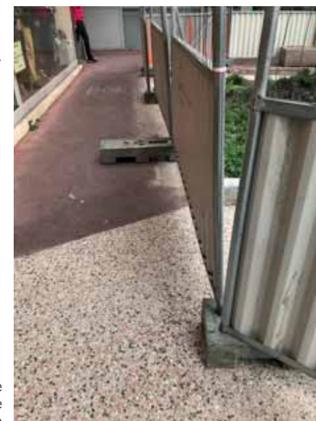
Les stabilisateurs de barrière de chantier doivent laisser libre le cheminement à 1,40m minimum
